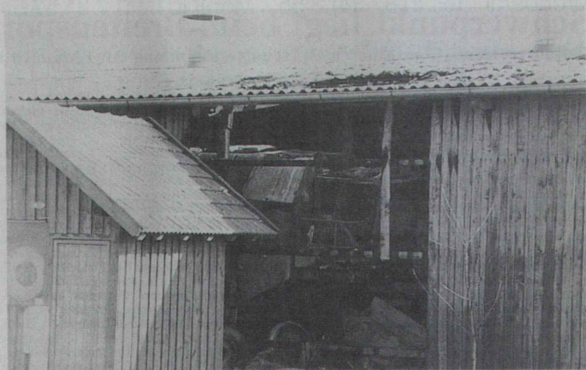
Ein Raub der Flammen wurde der im Stadel stehende Mähdrescher
