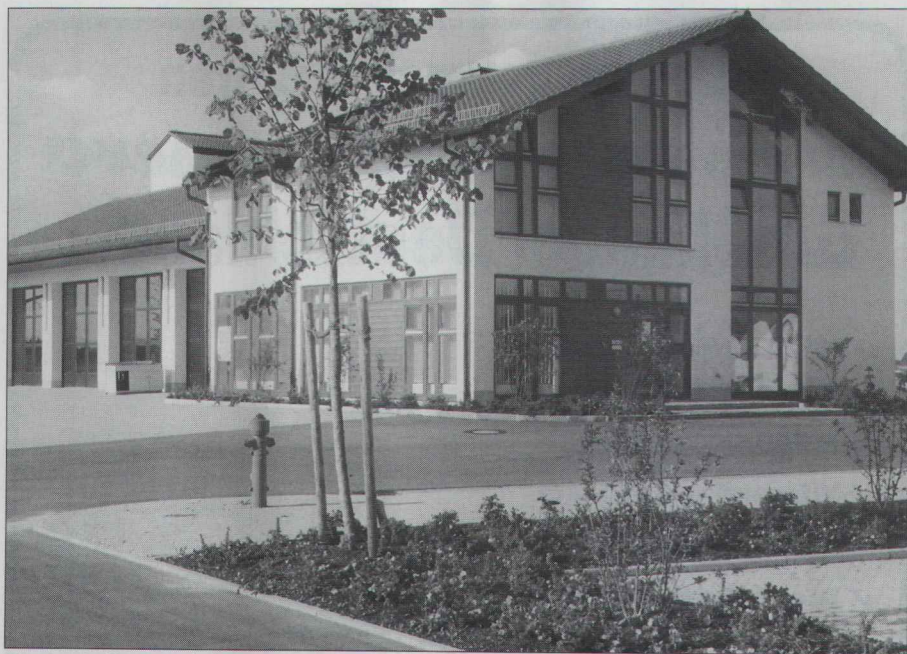
Das neue Feuerwehrhaus.
