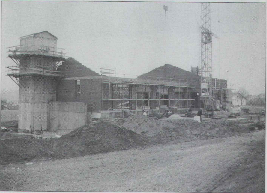
Rohbau des neuen Heims der FFW Hohenthann.
